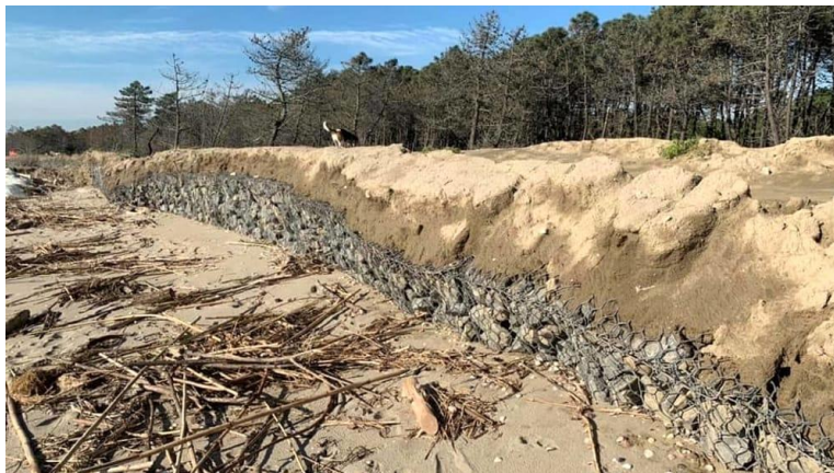
L'erosione del litorale a Lido di Dante (RA)
